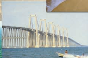
El puente Rafael Urdaneta. MARACAIBO.
