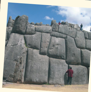
Muralla de piedras. CUZCO.
